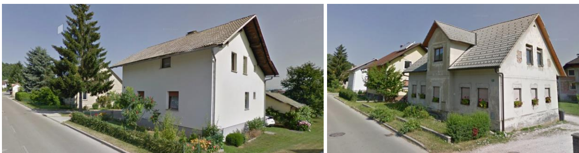
Stanovanjska zazidava ob severni strani ulice Vaše, ki poteka v smeri pribl. V-Z
