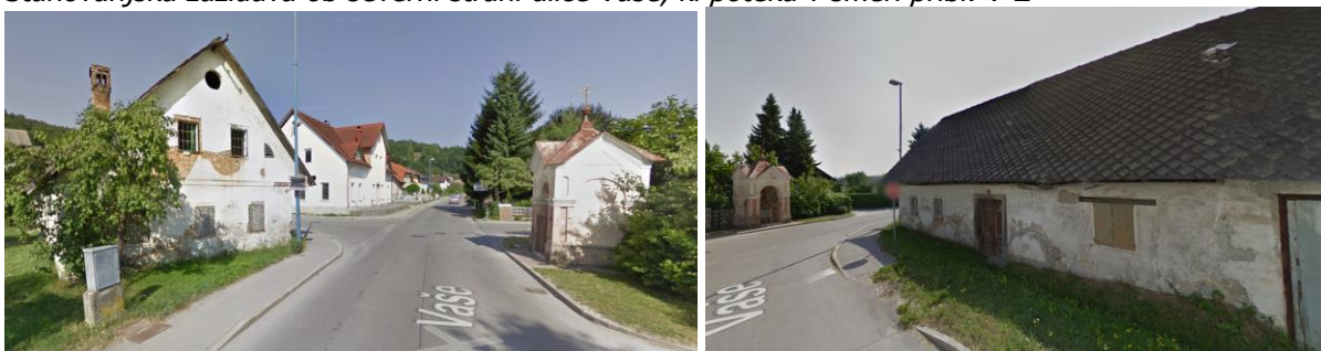
Vaška zazidava v križišču dveh ulic Vaše na zahodni strani območja EUP ME_651.
